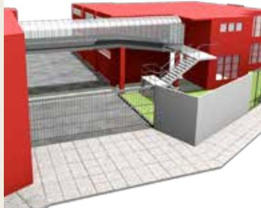
Se ampliará el Cuartel de Bomberos Cosmopolita 11. El proyecto consiste en la ampliación del segundo nivel del cuartel destinando un ambiente para damas, la instalación de un puente peatonal y una escalera de estructuras metálicas, cuyo fin es agilizar el desplazamiento del personal para la atención de emergencias que se susciten en el distrito.
